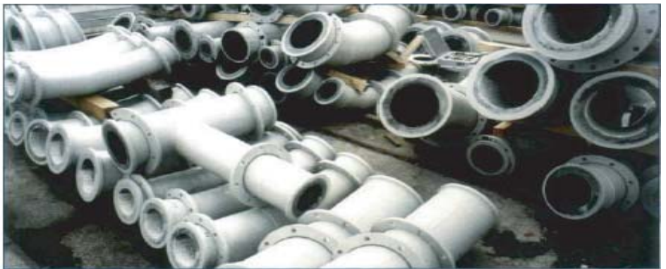
Трубопровод перед сборкой
